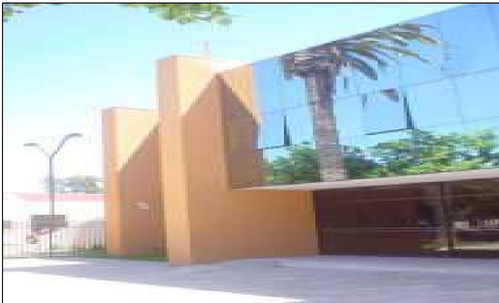
Hospital de San Javier
