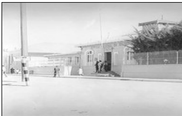
ANTIGUO HOSPITAL DE OVALLE
