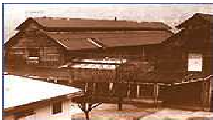
Pabellones donde funcionó el Hospital Naval de Valparaíso dentro del Hospital Carlos Van Buren.
