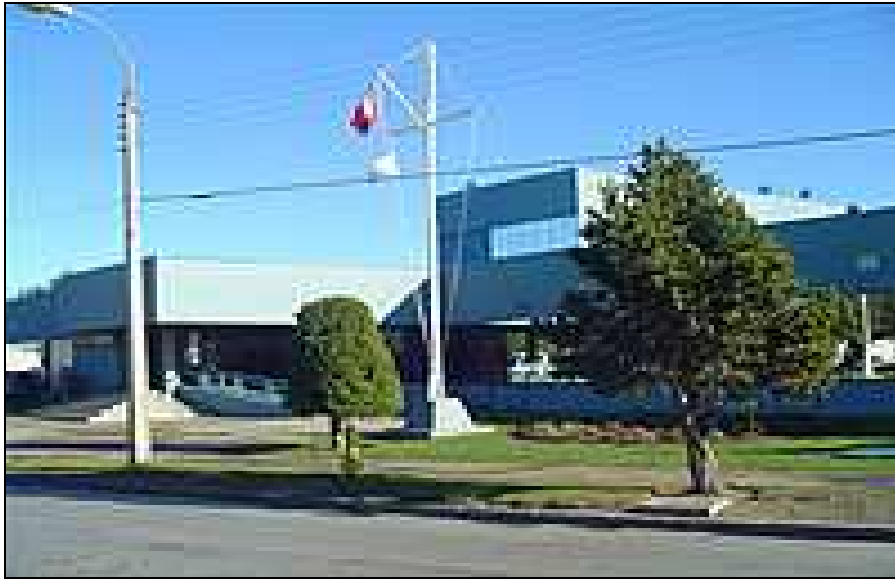
Nuevo Hospital Naval de Punta Arenas
