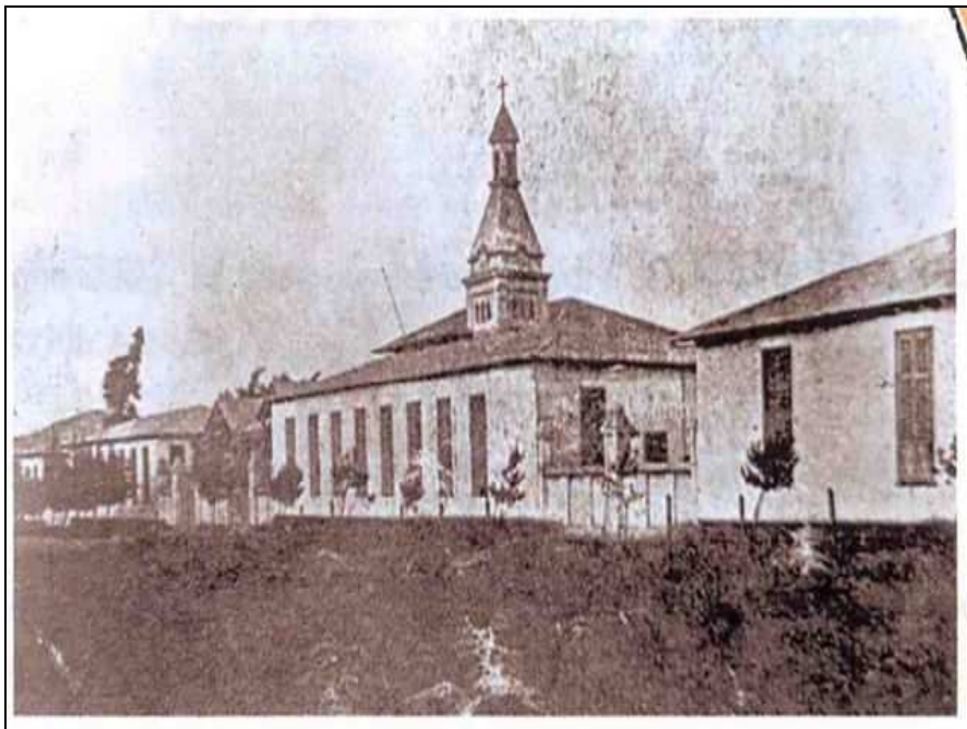
Vista del Hospital de Melipilla desde el Parque Municipal
