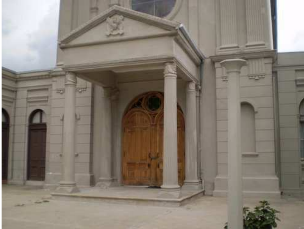
Pórtico restaurado de la Iglesia del Hospital Santo Tomás
