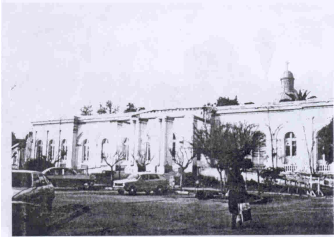
Frontis del Hospital del Salvador después del terremoto de 1985
